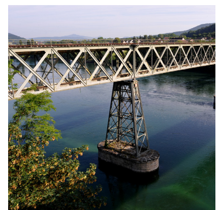
Vue partielle d'un pont sur le Rhin avec des piliers triangulaires construit par Christian Kleis à Hemishofen
